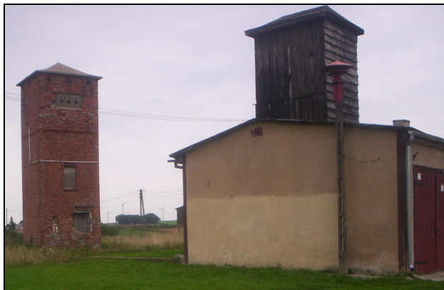
Ochotnicza Straż Pożarna i rozdzielnia prądu obecnie
