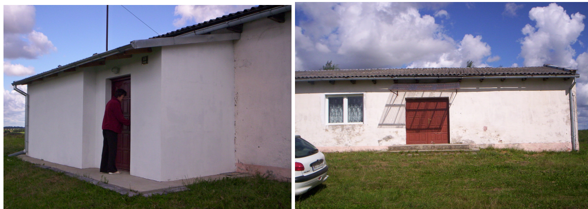
Świetlica w Łęgowie
