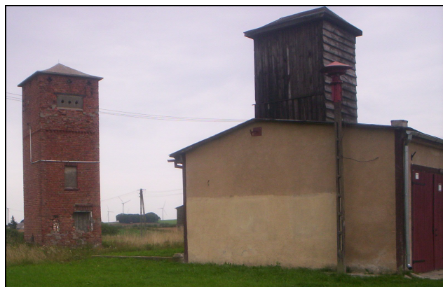
Ochotnicza Straż Pożarna i rozdzielnia prądu obecnie
