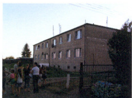
Jeden z bloków mieszkalnych
