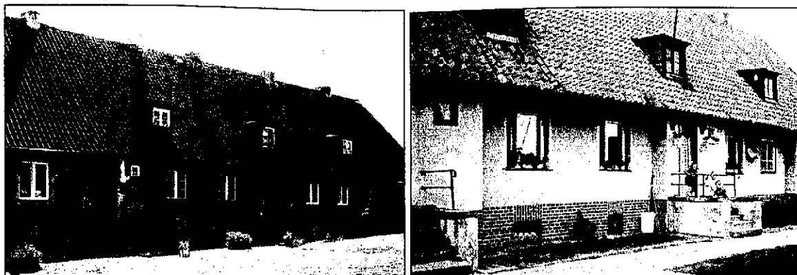
Kompleks budynków po dawnej szkole w Butowie
