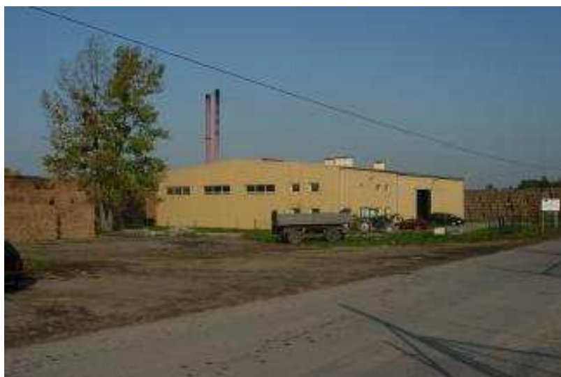
Rys. 10. Ciepłownia miejska zasilana biomasą
