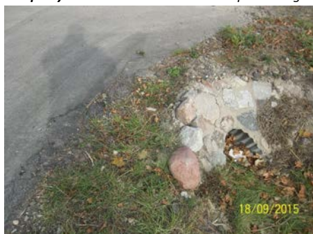
Przepusty - luźne kamienie zabruku do ponownego montażu
