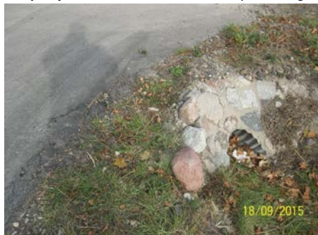
Przepusty - luźne kamienie zabruku do ponownego montażu
