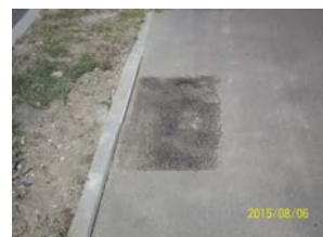
źle wykonana "łata" - niedowałowane , masa gruboziarnista
