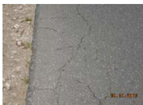
uszkodzona/spękania krawędź
