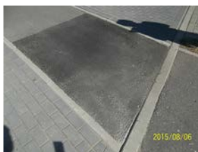
źle wykonana "łata" - niedowałowane , masa gruboziarnista
