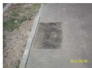
źle wykonana "łata" - niedowalowane, masa gruboziarnista
