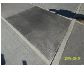
źle wykonana "łata" - niedowalowane, masa gruboziarnista
