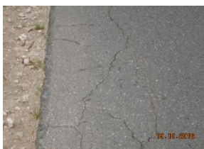
uszkodzona/spękania krawędź
