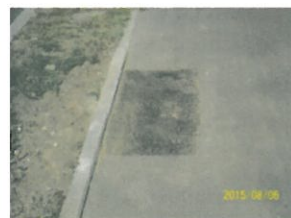
źle wykonana "łata" - niedowałowane, masa gruboziarnista
