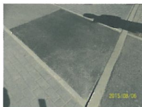
źle wykonana "łata" - niedowałowane, masa gruboziarnista
