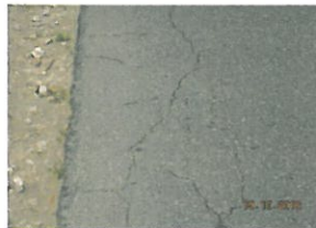
uszkodzona/spękania krawędź
