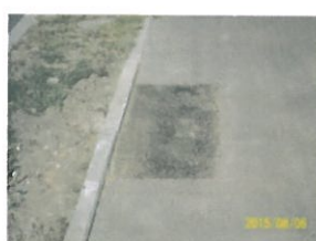
źle wykonana "łata" - niedowałowane, masa gruboziarnista
