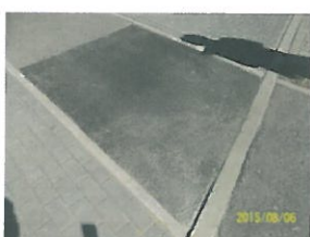
źle wykonana "łata" - niedowałowane, masa gruboziarnista
