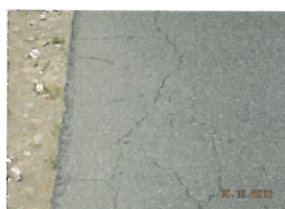
uszkodzona/spękania krawędź
