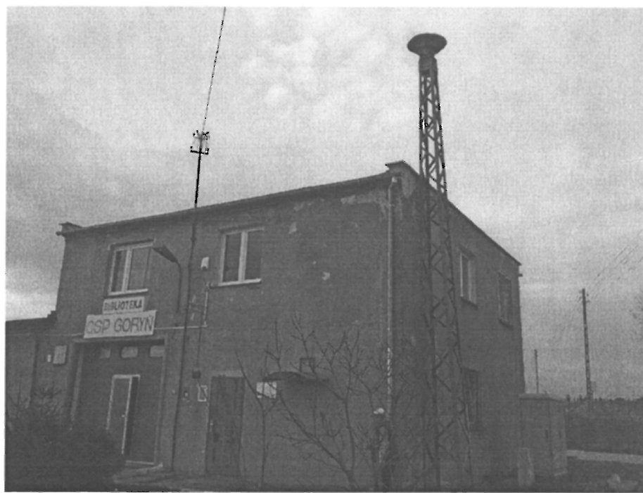
Fot. nr 2. Widok elewacji południowej.
