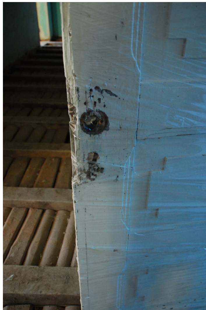
Fot. 31,32 Piętro budynku. Fragment zachowanej oryginalnej stolarki drzwiowej z widocznymi uszkodzeniami zewnętrznych ramiaków pionowych.
