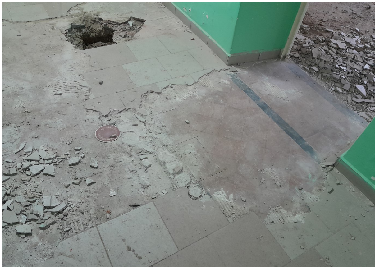
Fot. 25 Suterena. Oryginalna ceramiczna posadzka pokryta współczesnym gresem
