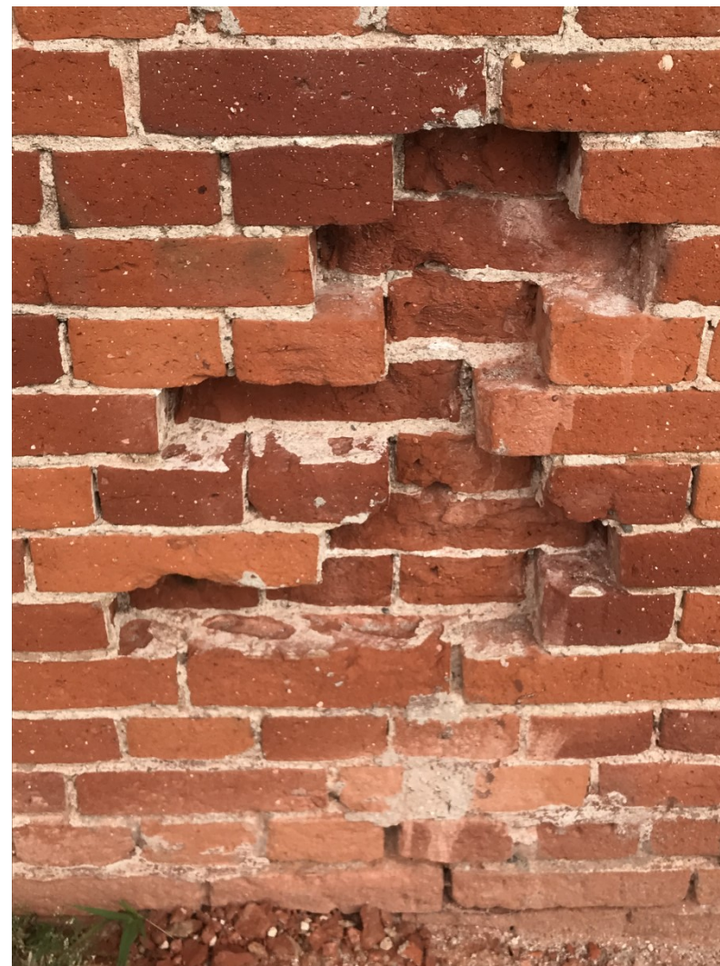
Fot. 13 Elewacja wschodnia. Fragment cokołu pokryty wtórną farbą z widocznymi wykwitami soli. Fot. 14 Elewacja zachodnia. Fragment strefy cokołowej po usunięciu uszkodzonych lub wtórnych cegieł.
