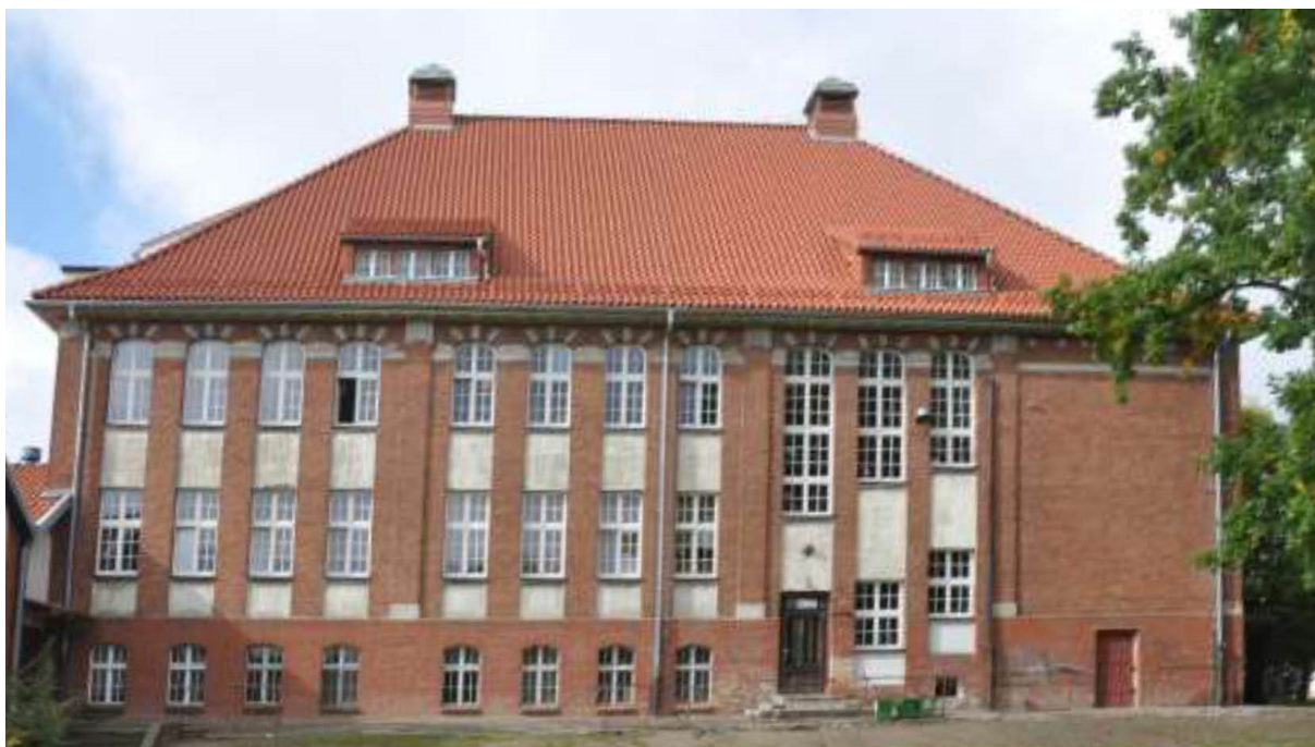
Fot. 1 Budynek szkoły w Kisielicach. Widok na elewację zachodnią.
