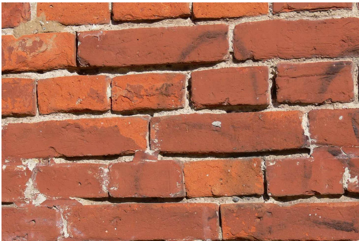
Fot. 9 Elewacja wschodnia fragment strefy cokołowej pokrytej wtórną farbą.
