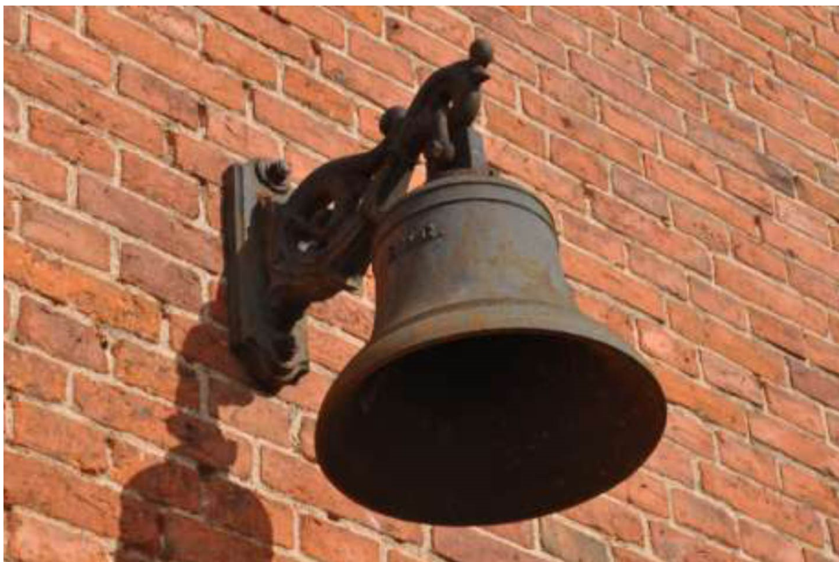
Fot. 19 Elewacja południowa. Zachowany pierwotny dzwonek.
