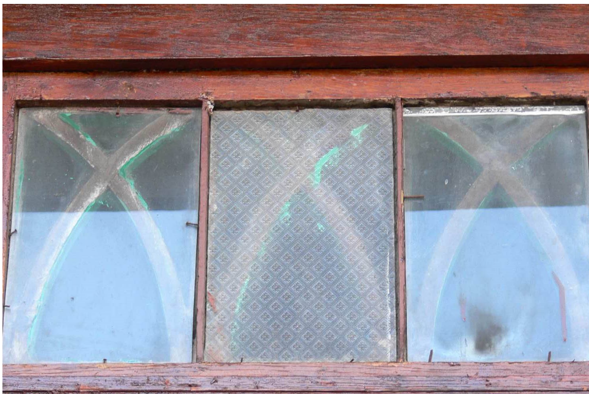
Fot. 17 Wejście główne. Fragment nadświetła z wtórnym oszkleniem.
