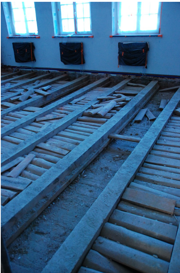
Fot. 33,34 Piętro budynku. Zdemontowana podłoga deskowa w salach lekcyjnych.
