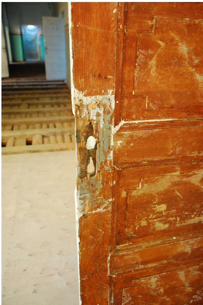
Fot. 31,32 Piętro budynku. Fragment zachowanej oryginalnej stolarki drzwiowej z widocznymi uszkodzeniami zewnętrznych ramiaków pionowych.
