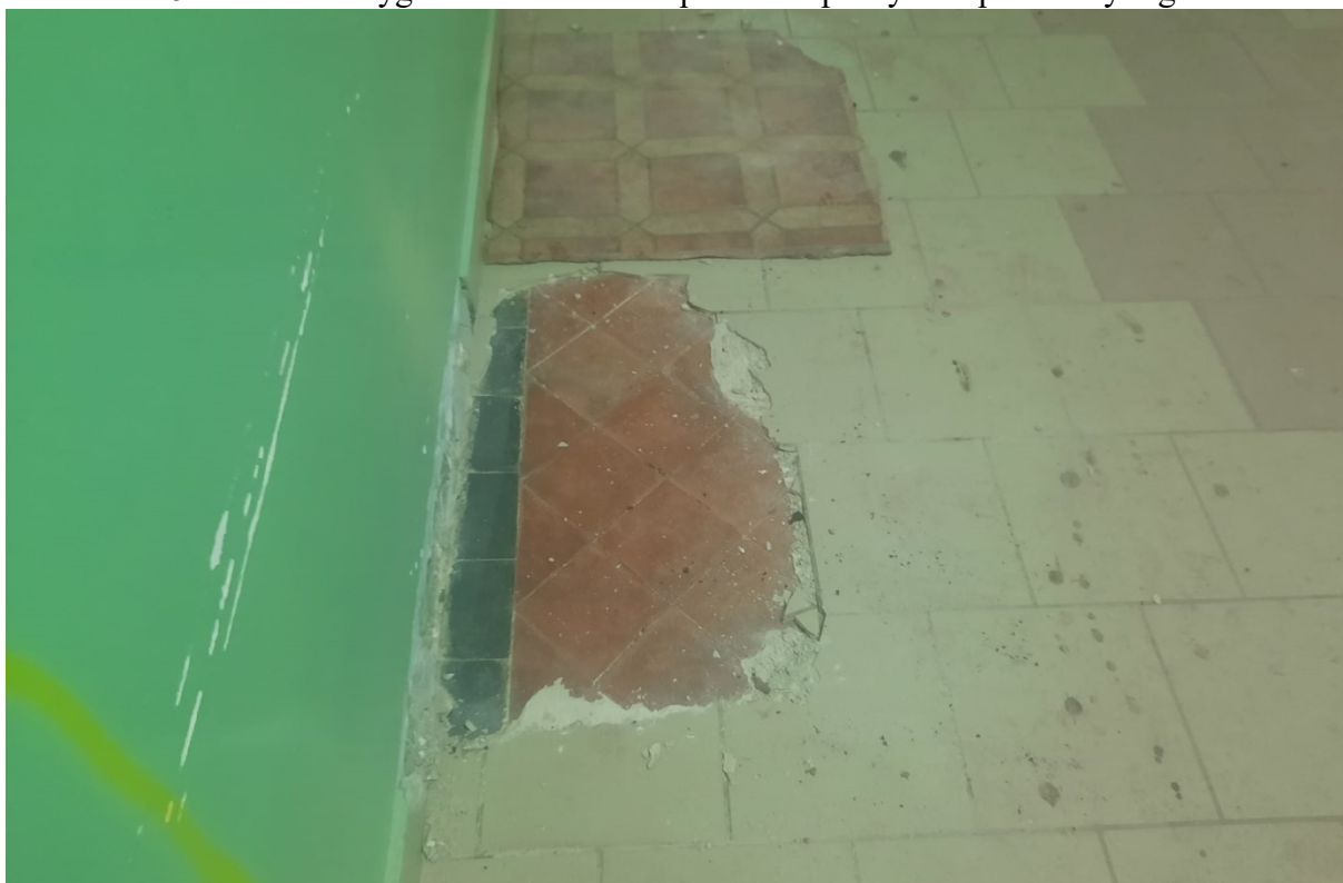
Fot. 26 Suterena Odkrywka z widoczną pierwotną podsadzka ceramiczną.
