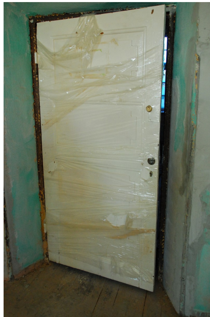
Fot. 27,28 Piętro budynku. Zachowana oryginalna stolarka drzwiowa z częściowo usuniętą farbą oraz zdemontowanymi klamkami i zamkami.
