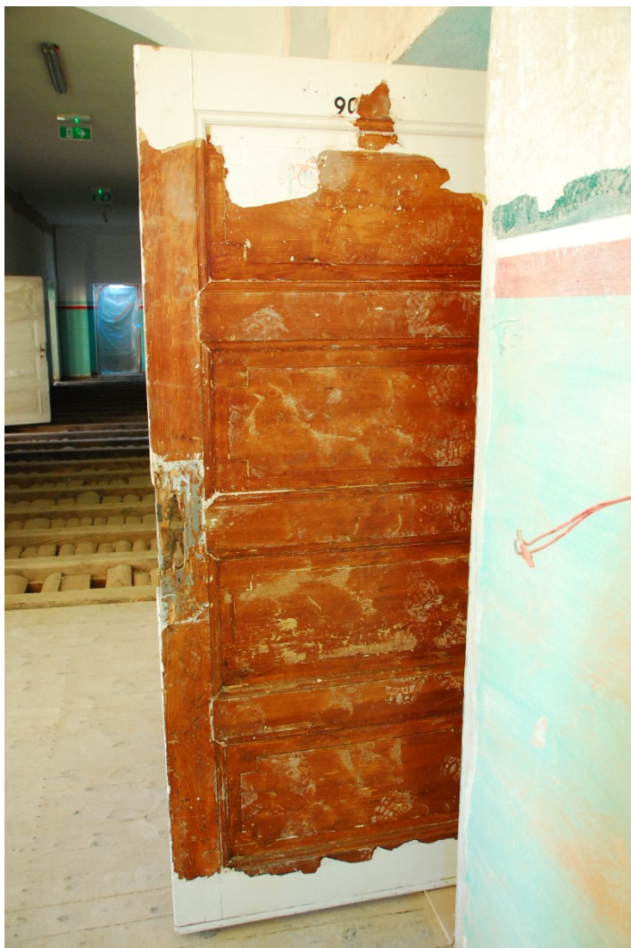
Fot. 27,28 Piętro budynku. Zachowana oryginalna stolarka drzwiowa z częściowo usuniętą farbą oraz zdemontowanymi klamkami i zamkami.
