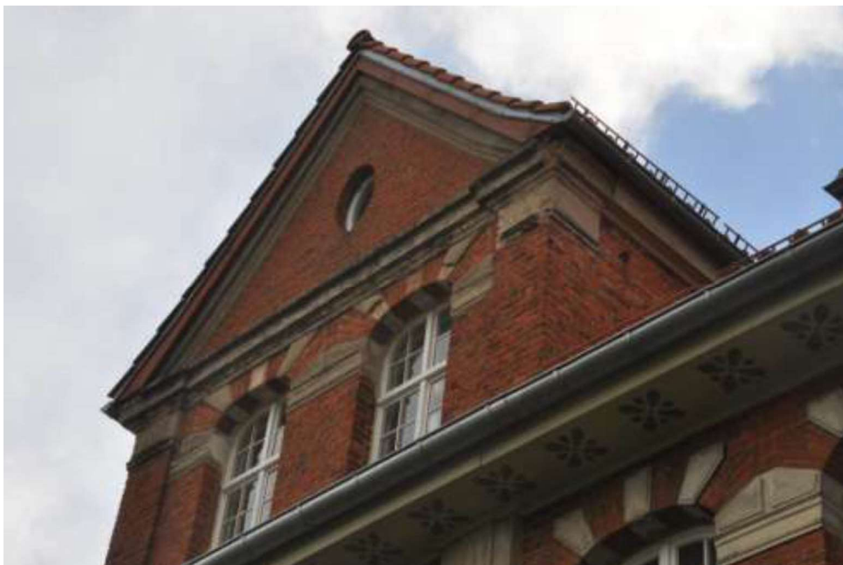
Fot. 4 Elewacja północna. Widok na facjatkę z oculusem.
