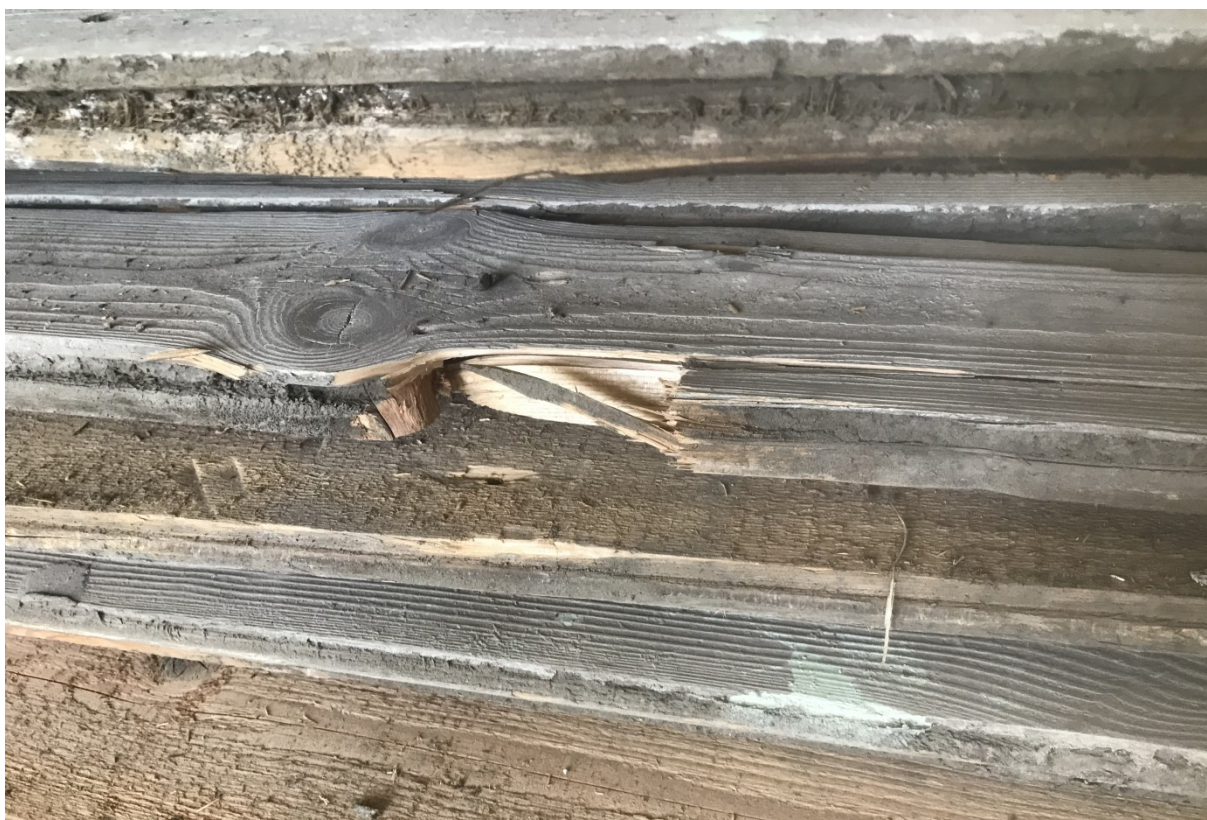
Fot. 35,36 Piętro budynku. Zdemontowana podłoga deskowa w salach lekcyjnych.
