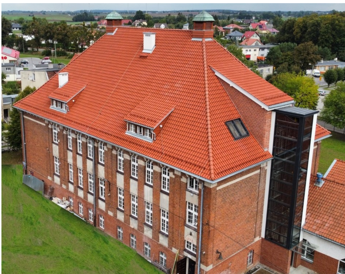
Fot. 2 Budynek szkoły w Kisielicach. Widok na elewację południowo-zachodnią.
