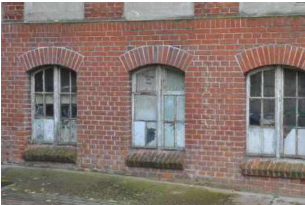
Fot. 3 Elewacja wschodnia. Widok na partię cokołową.
